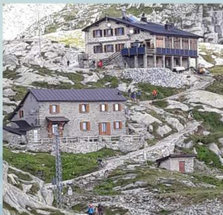
ultimo tratto in vista del rifugio Tita Secchi,2367;lago della Vacca
